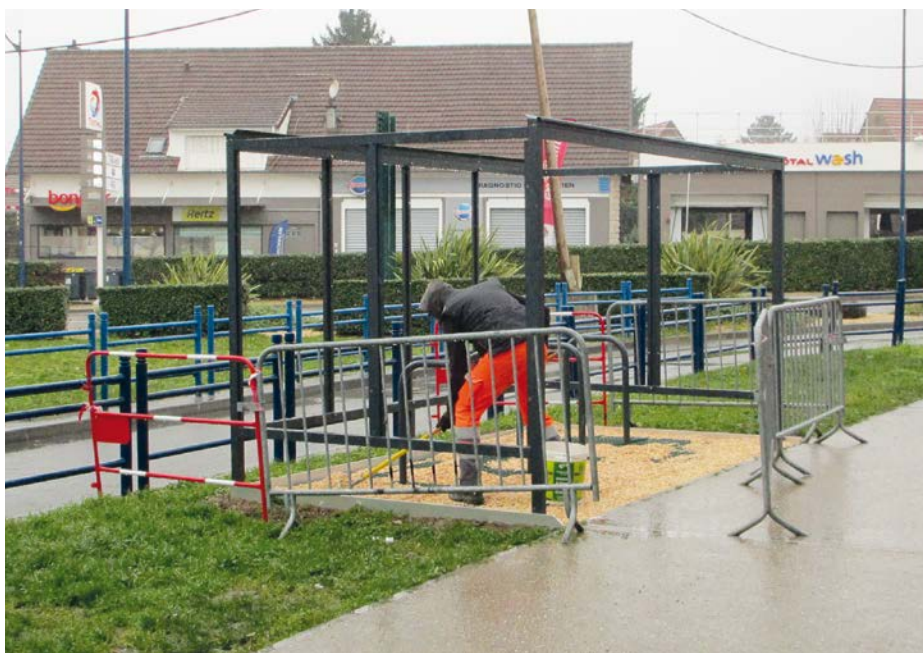
➔ Les travaux de voirie se déroulent aussi sous la pluie. En janvier 2021, l'équipe installait l'abri à vélos devant le cinéma de l'Ysieux.
