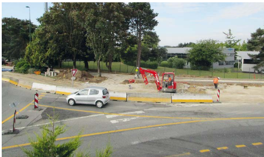
→ Les travaux avancent sur la RD922 : on devine la voie cyclable à l'arrière plan du chantier, qui passe entre les arbres.
