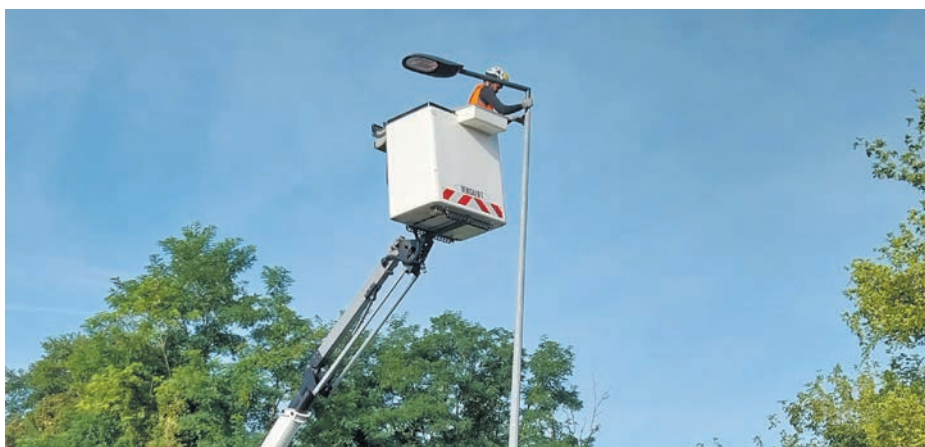
→ Citéos en pleine action avenue Camille-Laverdure, en face de la rue du Maréchal-Foch le 21 août.
