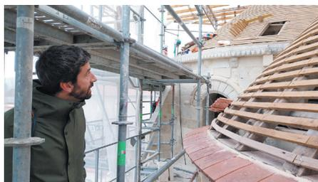
La pose de tuiles anciennes et de tuiles neuves en mélange sera bientôt complétée par des arêtières en mortiers de chaux, conformément aux dispositions historiques documentées.
