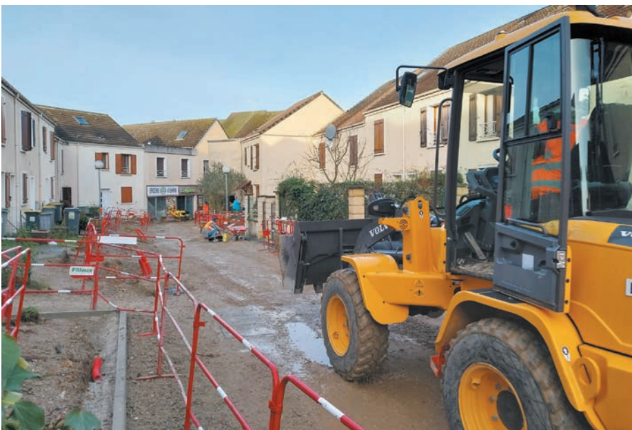
→ L'allée Serpollet en plein travaux.
