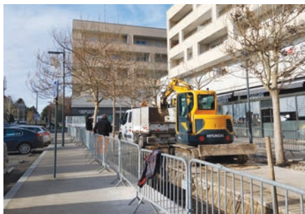
→ Sur la place du 19-Mars-1962, des dalles de béton désactivé ont été enlevées et les massifs sont creusés pour accueillir des plantations en février.
