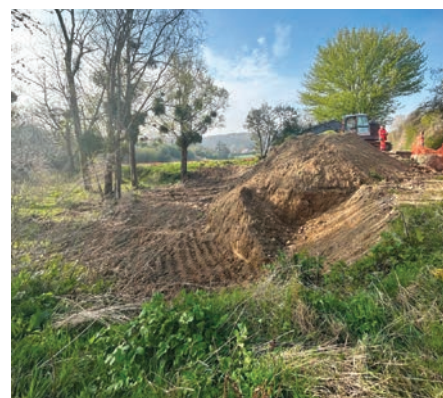
→ Travaux en cours sur le chemin rural n°8 de la Vallée aux prêtres pour contrer les ruissellements vers le village.
