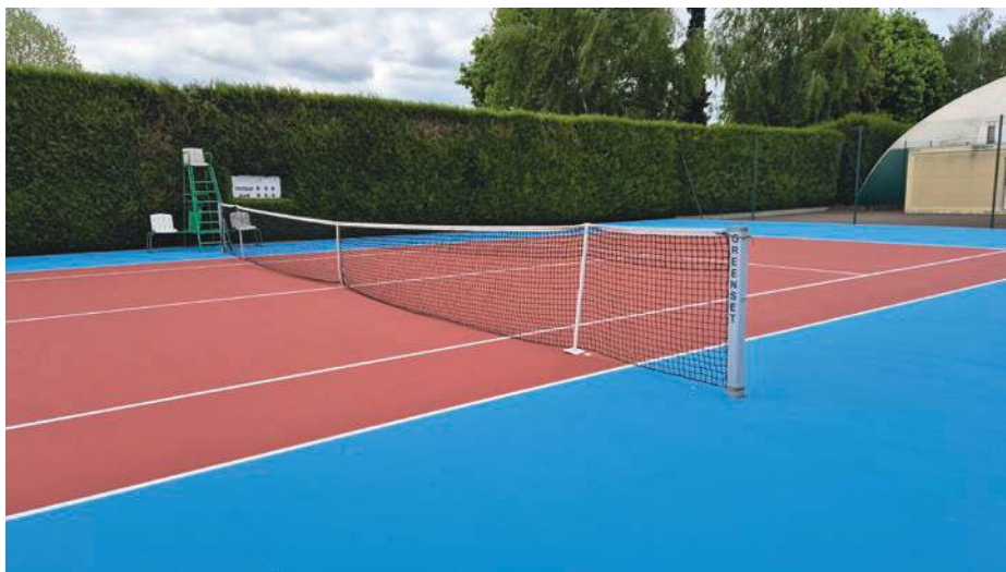
→ Le court de tennis proche du Cosec, bien connu des adhérents de l'Association Tennis de Fosses (ATF), a fait peau neuve. Supervisée par les services techniques, cette rénovation a été réalisée par l'entreprise Fieldservices en avril. Elle a coûté 13 200 €.
